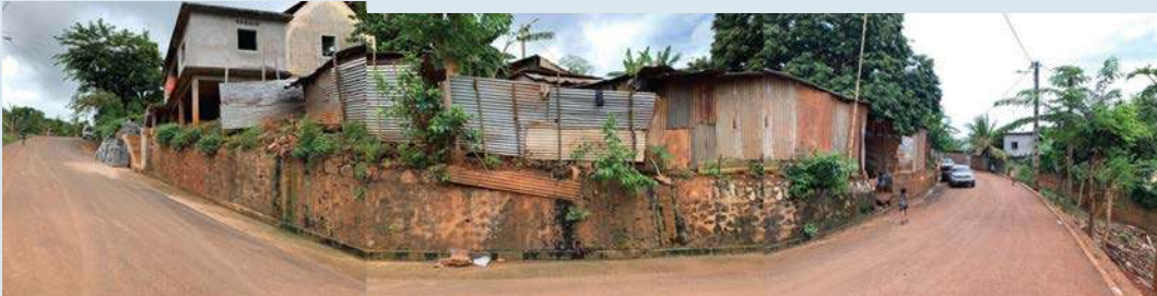
Vue sur la rue Mwandzani
